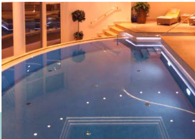
Edel-schillernde Optik: Ein mit „epple-plast SC“ beschichteter Pool wirkt fast wie ein Glasmosaikbecken (siehe auch „Schlusspunkt“ ab S. 140 im Hauptheft) – ist aber deutlich günstiger.
